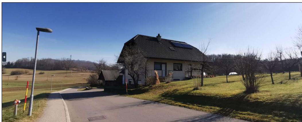
Slika 18: Obstoječi objekt ob območju OPPN
